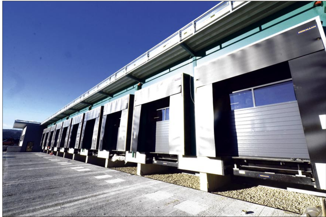
Die Rampen der neuen Auslieferungshalle. Ab Ende Jänner verlassen von hier aus täglich rund 50 Sattelkipper die Firma Windhager und liefern deren Produkte in ganz Europa aus. Bild: Rute
