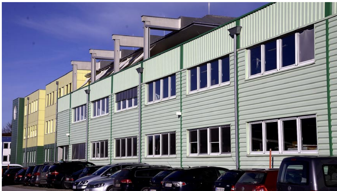
Auch Teile des Bürotraktes im Obergeschoss des Hauptgebäudes wurden im Rahmen der Hallenerweiterung ausgebaut.
